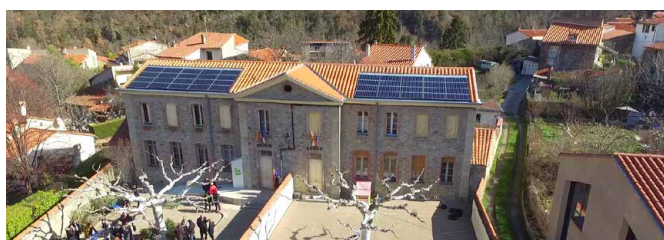
Mairie de Taurinya (66) équipée par Conflent Énergie.
