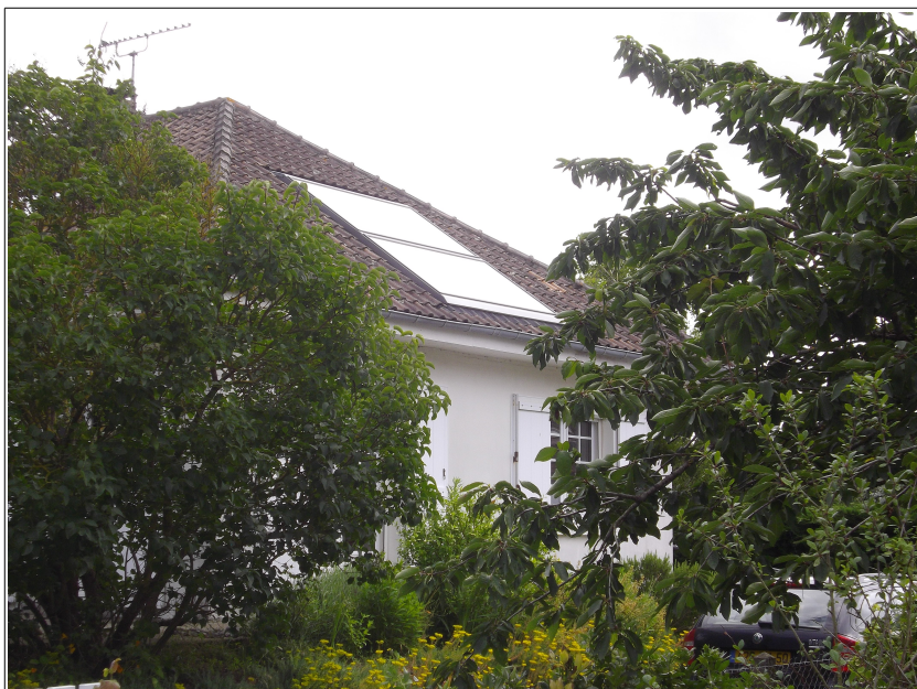
Vue sur la façade Sud
