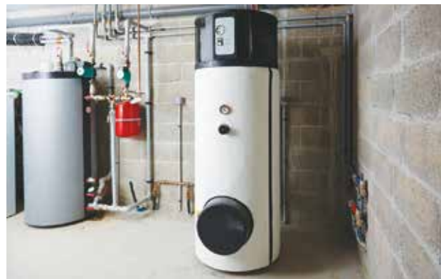
Chauffe-eau thermodynamique installé dans un sous-sol.
